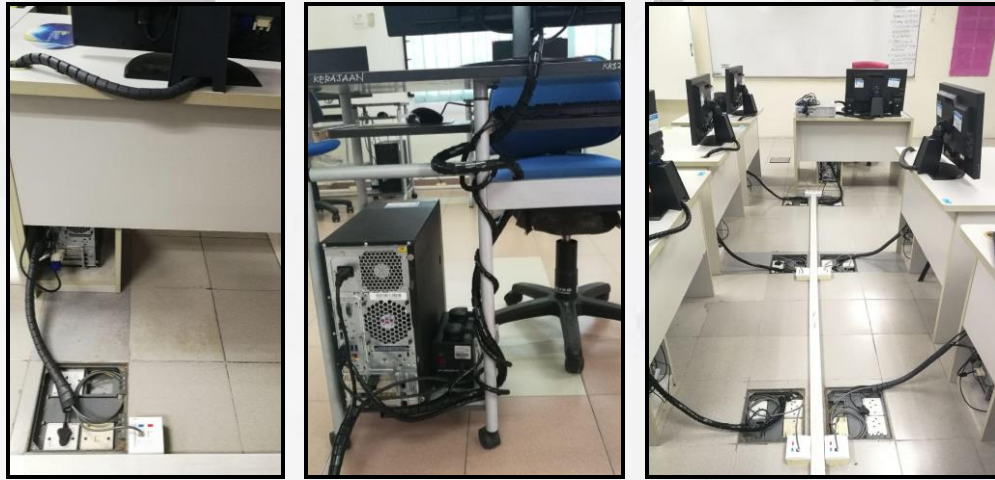
Ikatan kabel set komputer yang kemas
